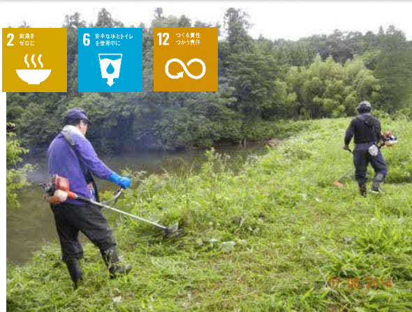
ため池堤体の草刈り
