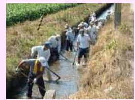
水路の泥上げ
