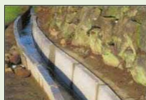
素堀り水路からの更新
