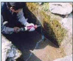
ひび割れの補修
