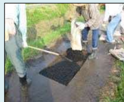
農道の部分補修
