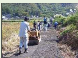
未舗装農道の舗装
