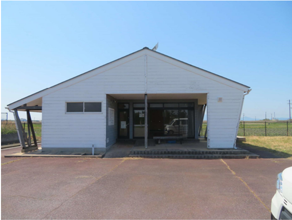
【施設外観】管理棟・駐車場
