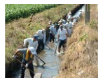
水路の泥上げ
