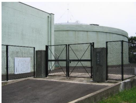
【社日配水池（社日地区）】
