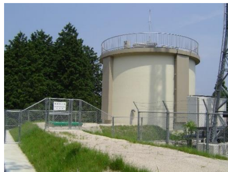
【滝谷配水池（比田地区）】
