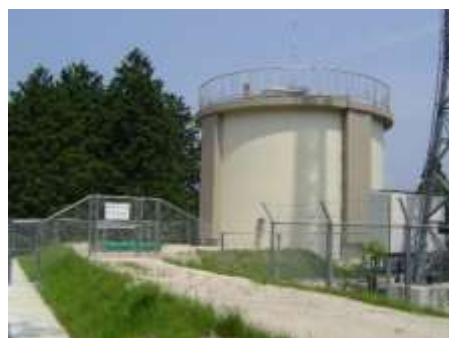
【滝谷配水池（比田地区）】
