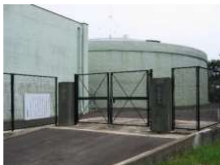
【社日配水池（社日地区）】
