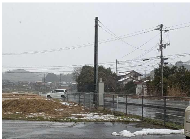
ポンプ制御盤
