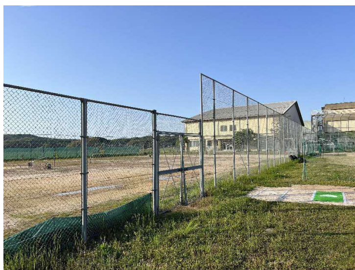
テニスコートと校庭境界のフェンスの状況（現状） （高さについては、関係機関と協議して決定）
