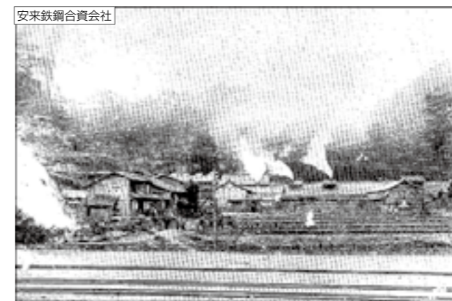
電気炉やつぼ炉による刃物鋼や工具鋼の生産を始める。
