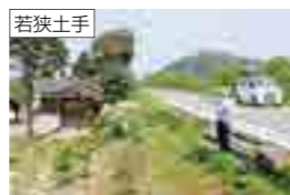
若狭土手 伯太町井尻から安来にかけてこれまで蛇行(だこう)していた伯太川をほぼ現在の形に整え、両側に堤防を築き、頻繁に起こっていた水害を防ぐことによりその川筋一体に水田を開く事ができました。
