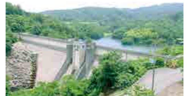
山佐ダムの堰堤
