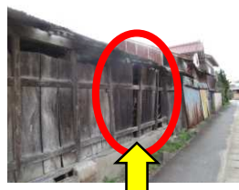
壁が固定されておらず、道路側に倒れてくる可能性がある
