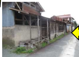
国道9号に向かって南進した場合。当該家屋は左手。
