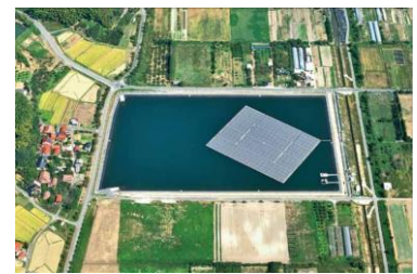
▲設備容量1MWのイメージ。穂日島調整池に浮かぶメガソーラー。約100m×125m 写真出典：第2次安来市総合計画
