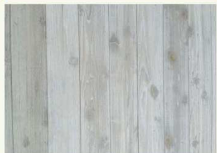
杉板型枠のRC打ち放し 低層部分のRC打ち放しに杉板型枠を用いることで、型枠からRCへと写った杉板の模様が周囲の自然との一体感を生む。
