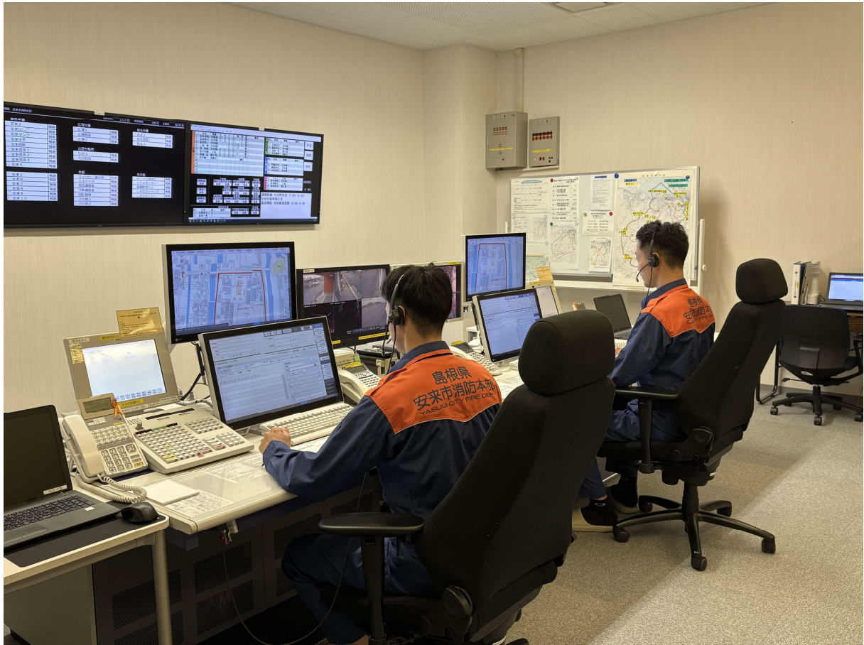
高機能消防指令システム
