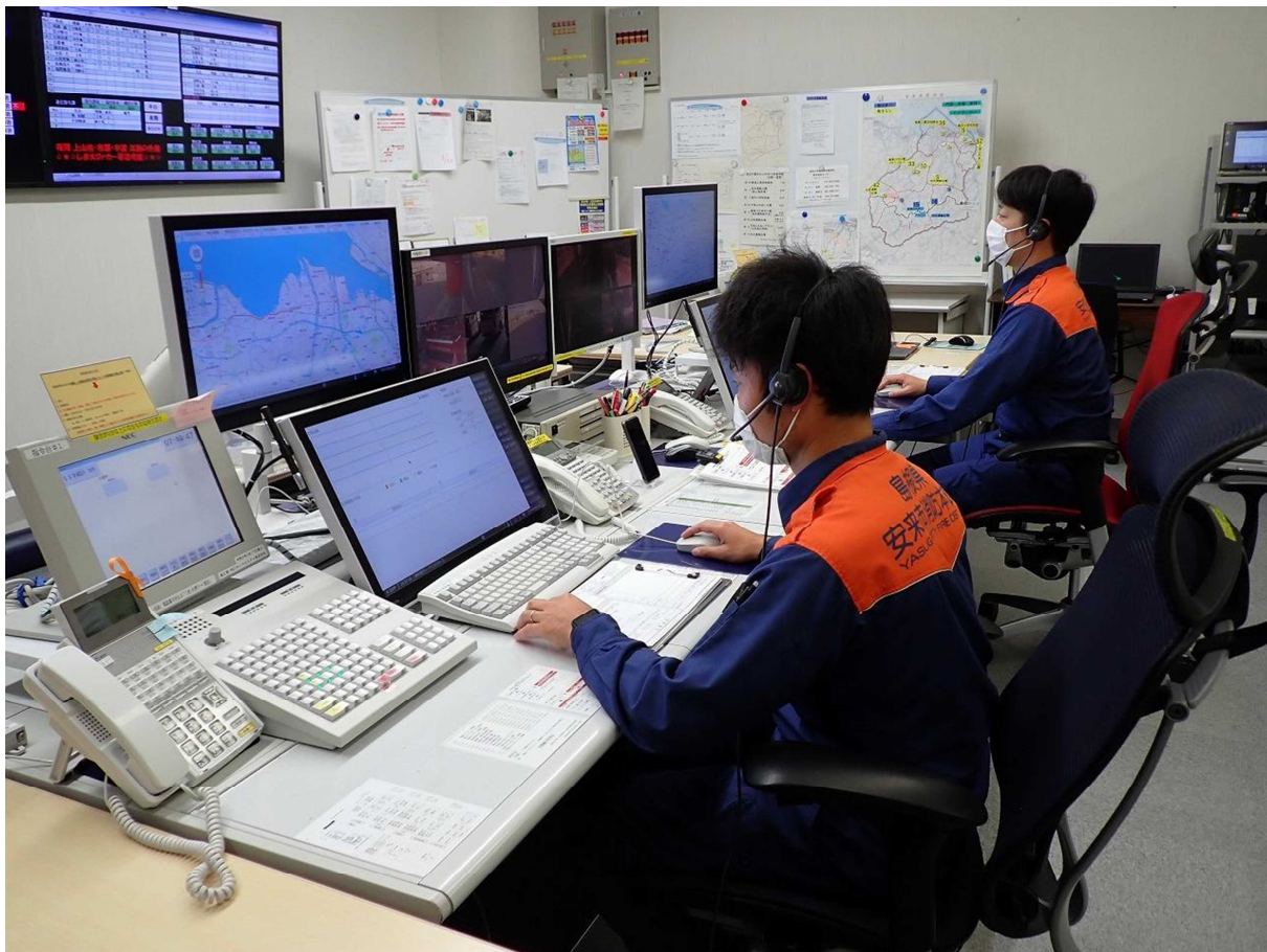
高機能消防指令システム
