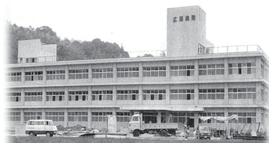
本館建設当時の様子
