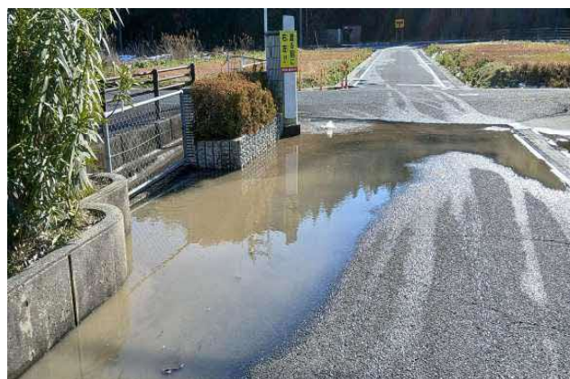
荒島小学校 水道設備
