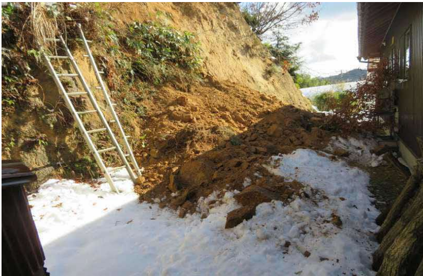
広瀬地区 西の谷林地崩壊災害
