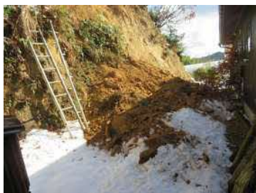
広瀬地区 西の谷林地崩壊災害
