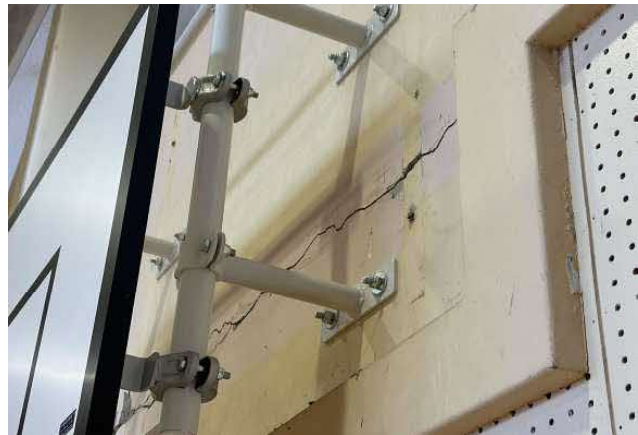
井尻小学校 体育館
