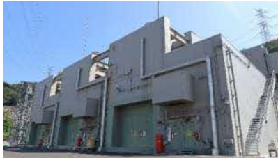
＜ガスタービン発電機(2台)＞
