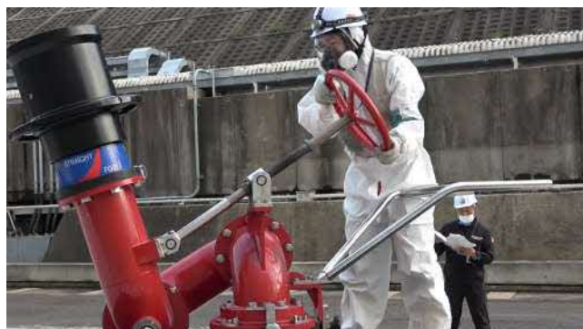
放水砲による放水準備
