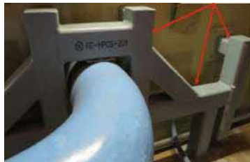
＜支持構造物(約1万箇所)＞
