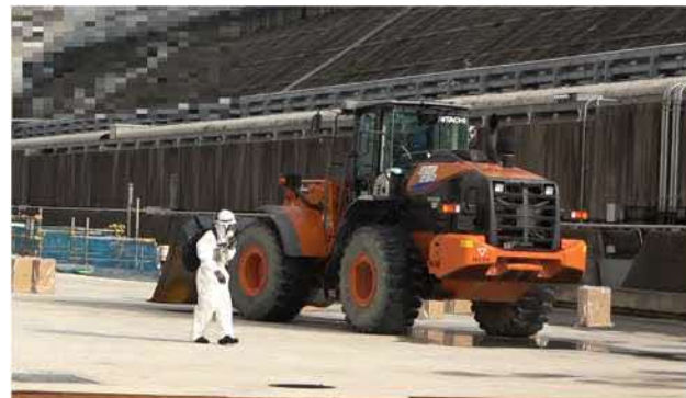
ホイールロードを使用したがれき撤去
