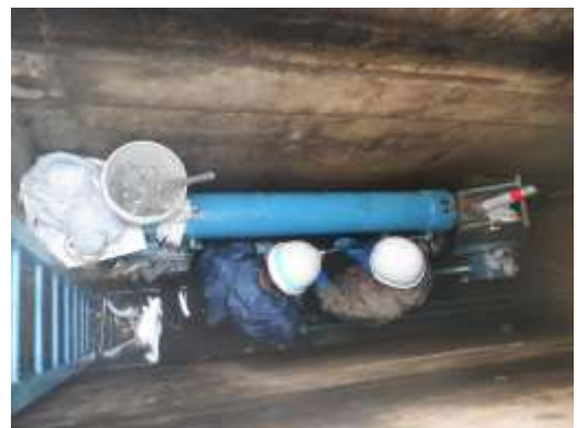
ゲート油圧部(油圧ホース交換)
