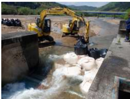
転倒ゲート部(大型土のう設置)
