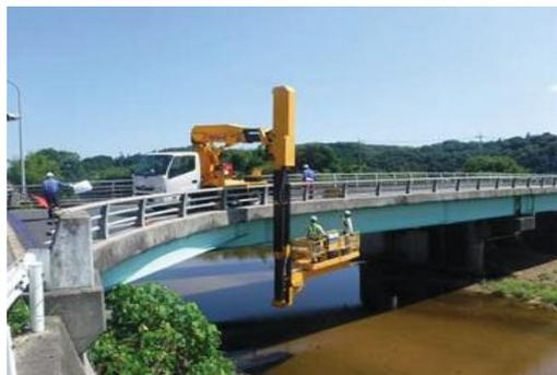
橋梁点検車による点検状況(上部)
