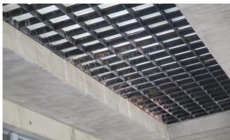
⑤認定こども園大塚テラス天井改修工事
