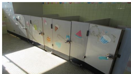
⑥安来保育所2階幼児トイレ改修工事
