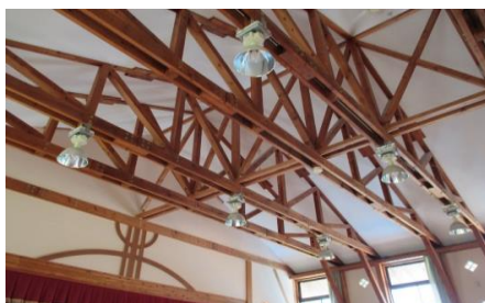
⑧認定こども園安田遊戯室水銀灯取替工事
