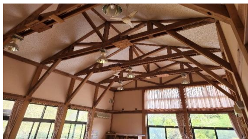
⑦認定こども園赤屋遊戯室水銀灯取替工事
