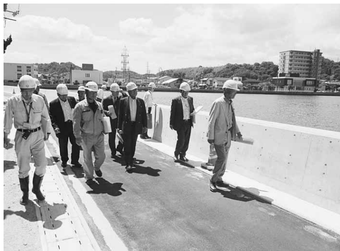
中海沿岸振興事業等調査特別委員会による 中海護岸整備工事の視察
