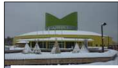
日本原燃（株）PR センター外観
