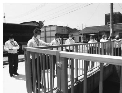
南十神雨水ポンプ場
