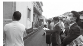
1月地震による市立病院外壁被害を確認する委員
