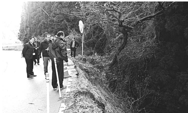
地域振興委員会による 道路橋りょう災害復旧事業現場視察 (伯太町上小竹)
