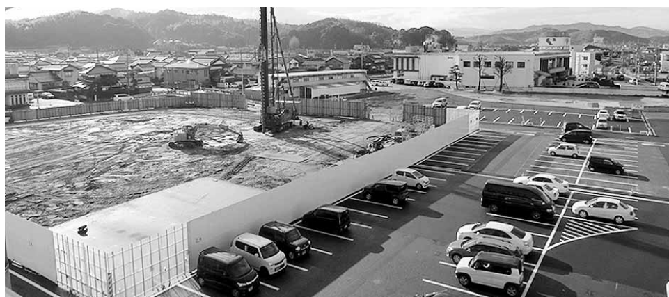
新安来庁舎建設地（安来町）
