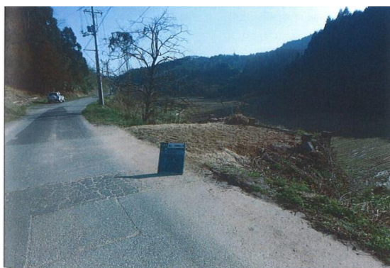
増圧ポンプ所解体撤去工事 寸次ポンプ所
