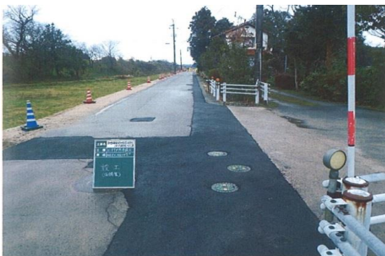
農地整備事業（経営体育成型）安田地区に伴う水道管移転工事
