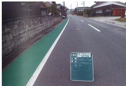
カラー舗装新設（下坂田町地内）
