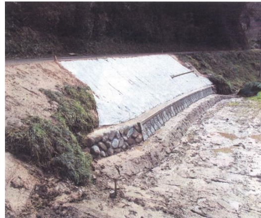
補助災害 大平線道路災害復旧工事竣工
