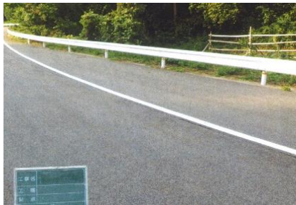
防護柵新設（広瀬町西谷地内）
