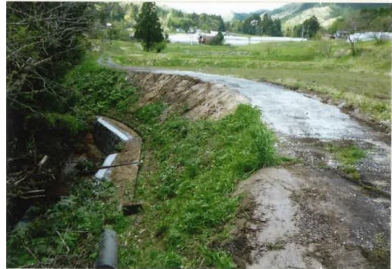
追神水路災害応急工事
