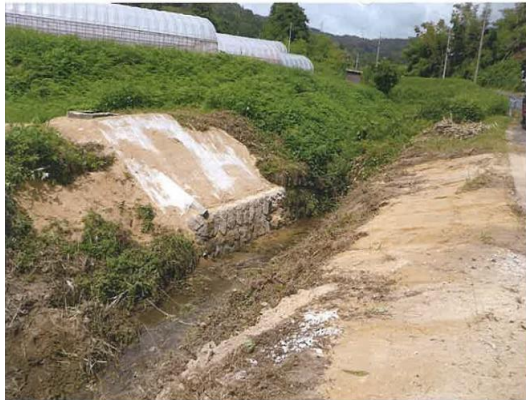
黒田水路災害応急工事
