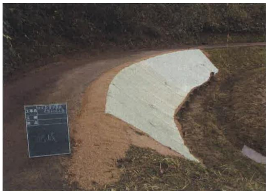
日次農道災害応急工事
