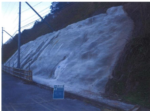
竣工（井尻福富線）
