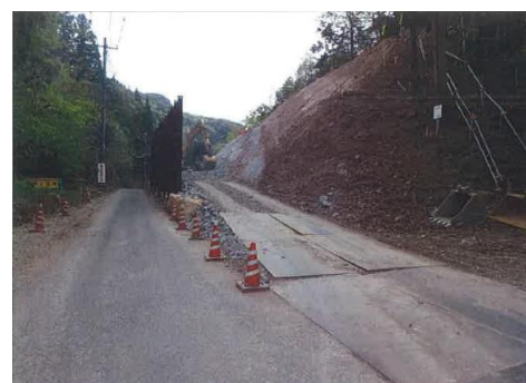
施工状況（5月時点）
