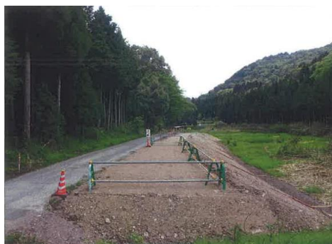
施工状況（5月時点）
