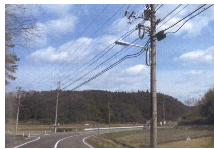
道路照明灯修繕（伯太町安田中地内）
