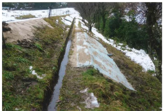
中口水路災害応急工事
