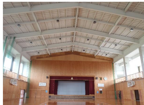
第三中学校吊天井施工後
