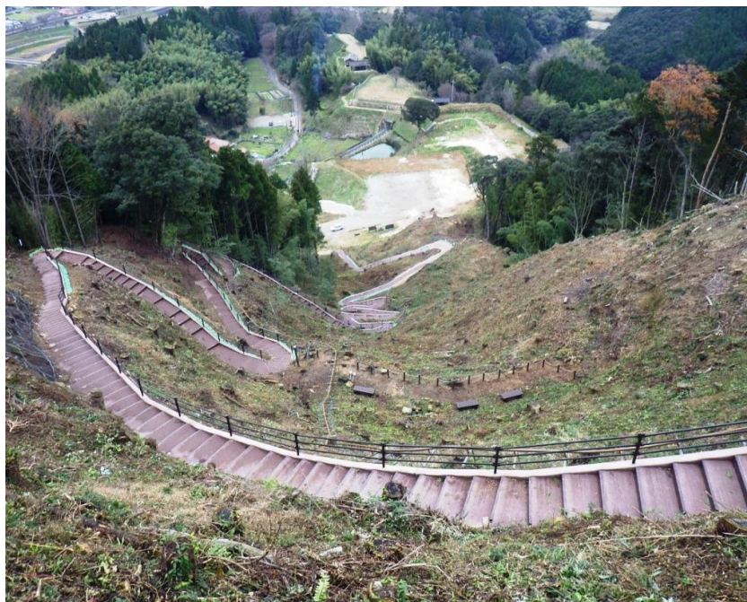
七曲り地区園路整備工事
