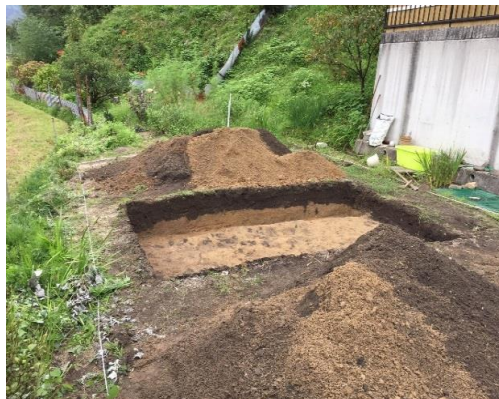
住宅増築工事予定地調査
