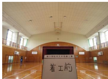
南小学校吊天井施工前
