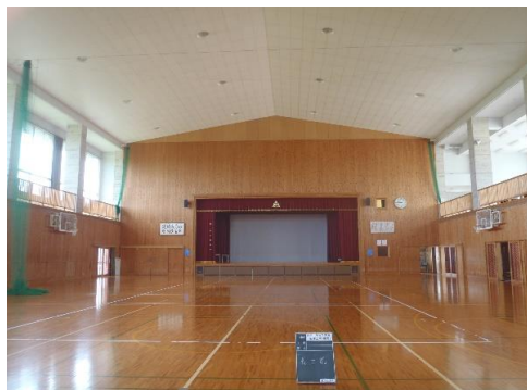
第三中学校吊天井施工前
