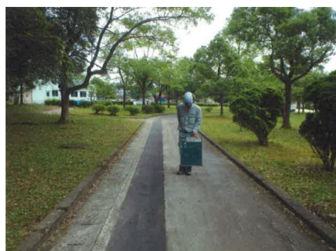
安来運動公園修繕工事
